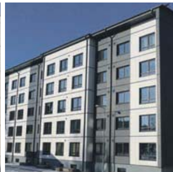
В конце 2017 года общежитие Akadeemia tee 5a стало первым реновированным зданием с почти нулевым потреблением энергии.
